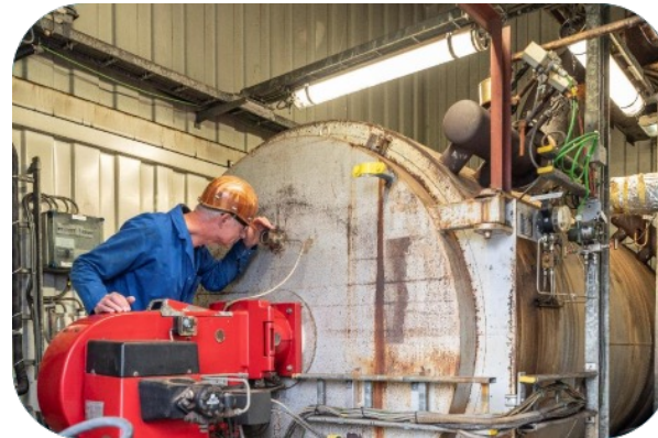
Aanpassing brander Nedmag mijnlocatie t.b.v. bijmengen waterstof 0-100%
